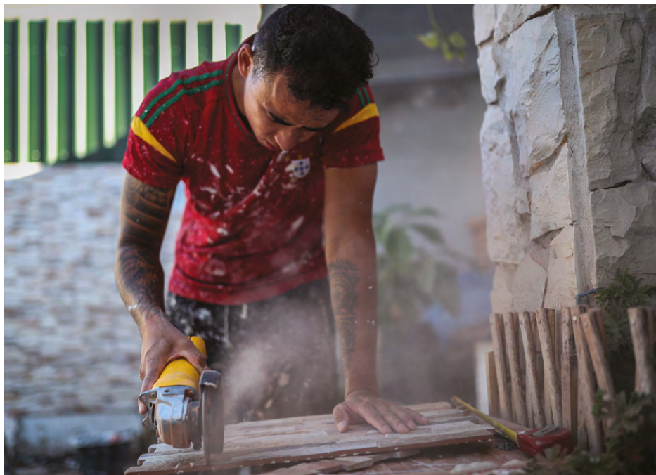
➤ Ein junger Mann arbeitet an einem Bauprojekt, Setúbal, Portugal, 5. August 2021.
